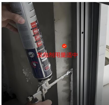
图 4.3.1-2 发泡剂施工
