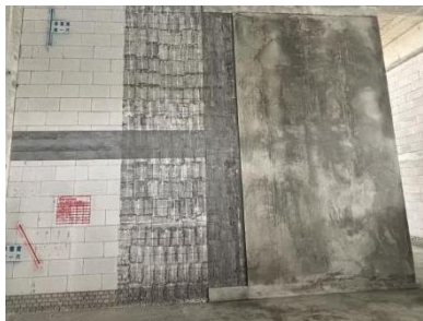
图 3.1.1-2 墙面抹灰施工
