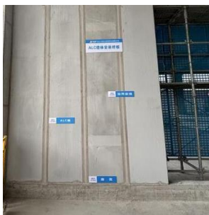
图 3.3.1-1 ALC 墙板安装样板
