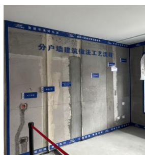
图 3.3.1-2 分户墙建筑做法及工艺流程
