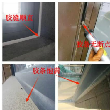
图 4.3.1-3 密封胶施工
