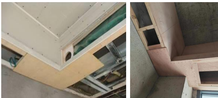
图 6.2.1-3 转角“L”型封板
