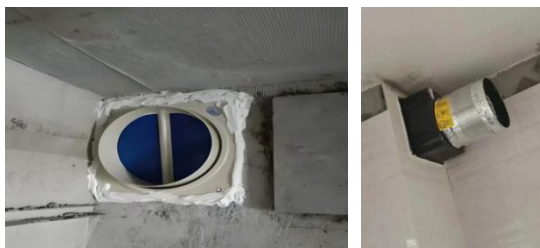
图 5.2-1 防火止回阀安装
