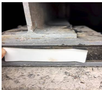
图 4.1.1-1 承重梁隔振元件
