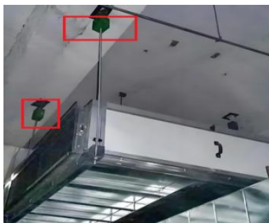
图 4.1.2-1 隔振器吊装
