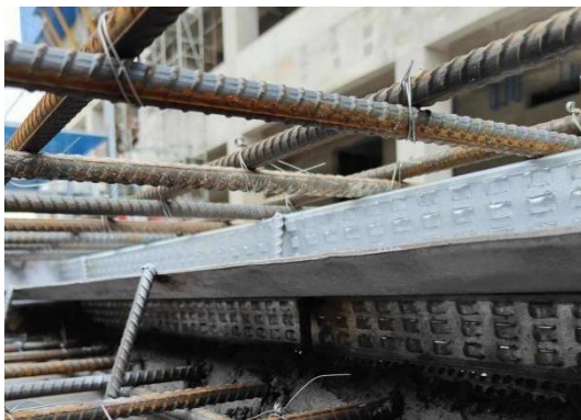
图 2.1.2-4 底板后浇带鱼鳞网片
