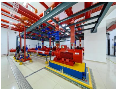
图 4.1.2-3 水泵设备安装
