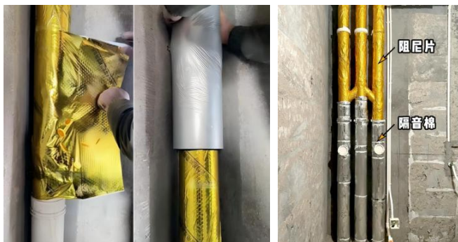
图 4.2.1-1 室内排水管隔音措施
